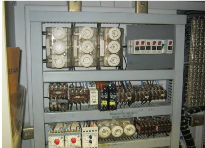
Bild 7: Hauptsicherungen HB Steibisberg
