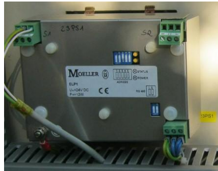
Bild 9: Leuchtmeldeinheit Bild 10: Busankoppler
