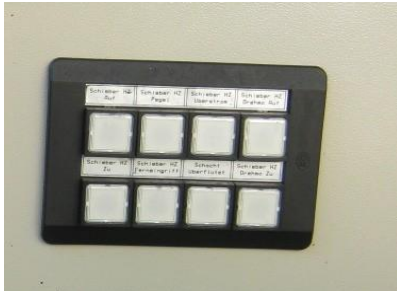
Bild 9: Leuchtmeldeinheit Bild 10: Busankoppler
