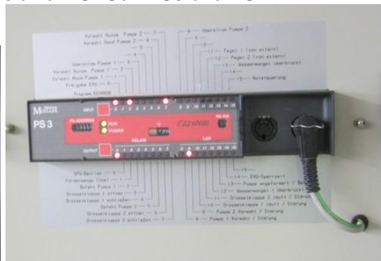
Bild 1: Hauptverteilung PW Karsee Bild 2: Moeller PS 3
