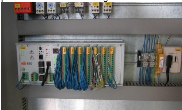
Bild 8: Fernwirkunterstation – IDS 650
