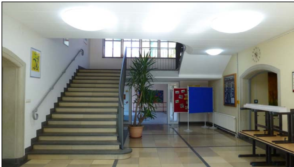
Foyer-Bereich mit akustisch wirksamer Decke und neuer Beleuchtung
