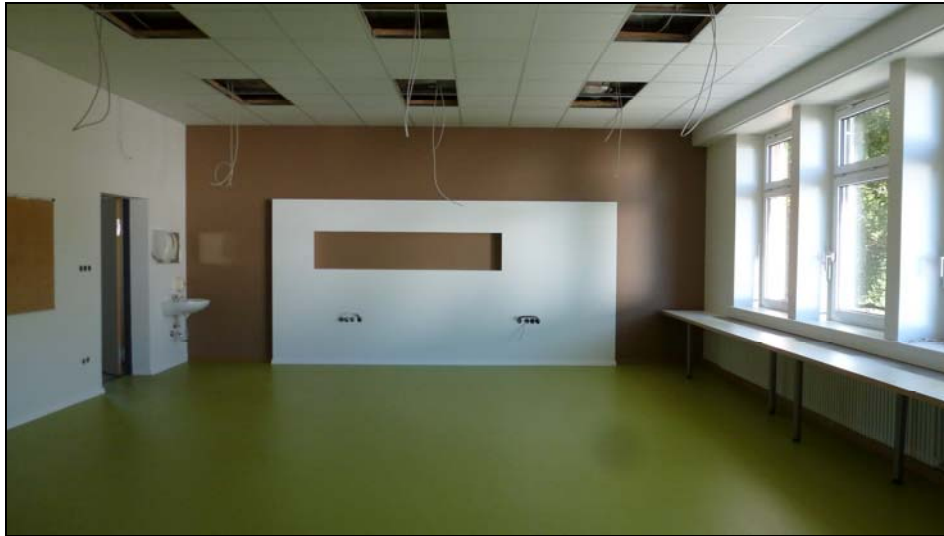
im Umbau befindlicher Klassenraum einer 5ten Klasse
